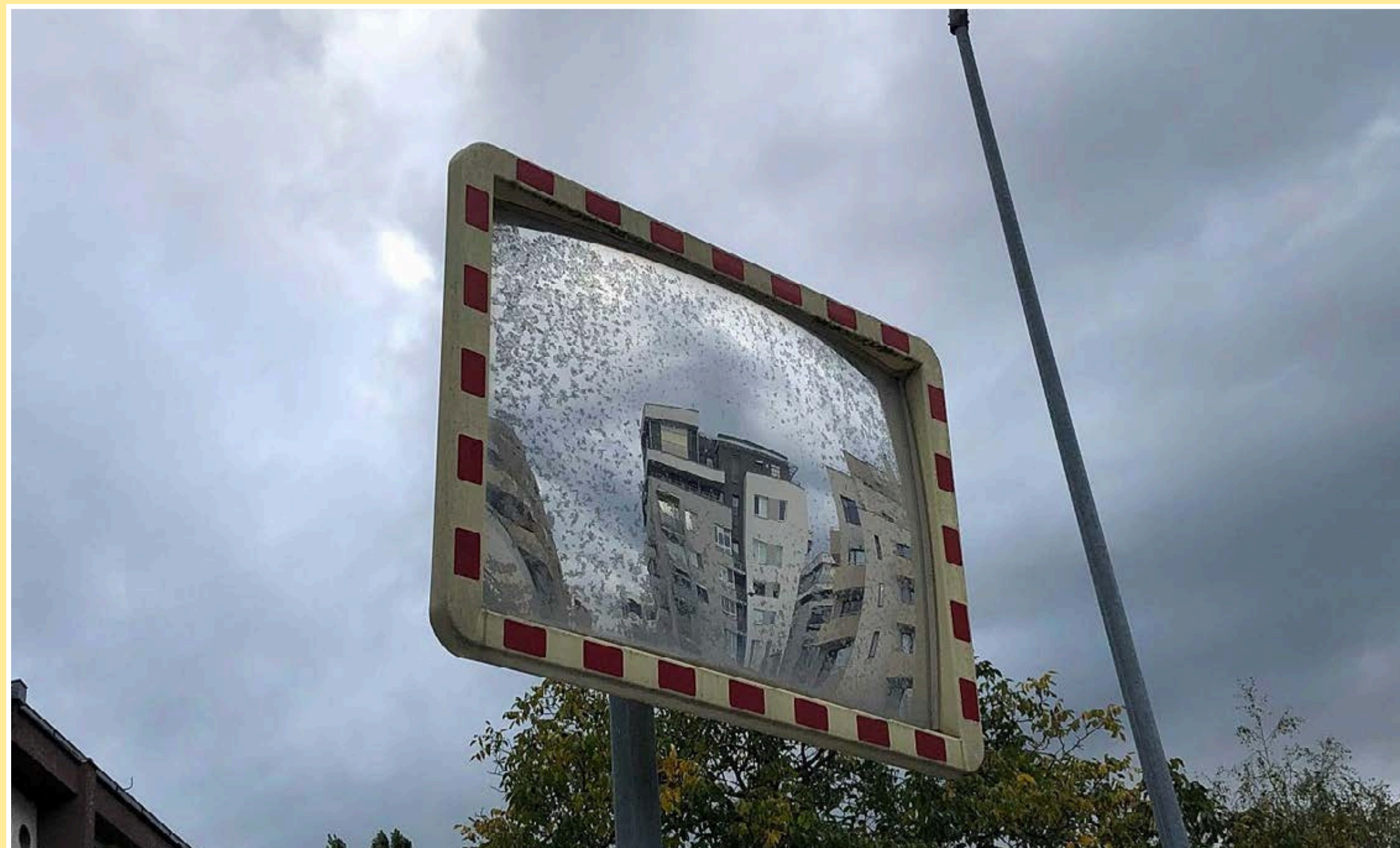
Poškozené dopravné zrkadlo
